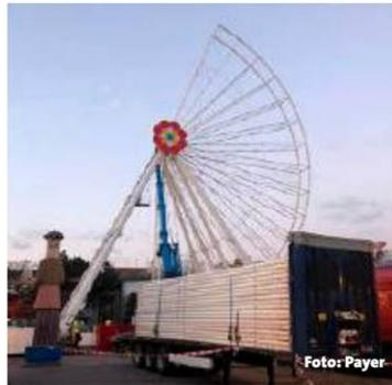
(kk). Vollständig überholt wird das Blumenrad im Wiener Prater in den Wintermonaten. Bei der Generalsanierung werden alle Verbindungen kontrolliert und sämtliche Lager getauscht. Nach dem Wiederaufbau im kommenden Jahr erhält das Blumenrad auch eine neue LED-Licht-Beleuchtung. In neuer Frische steht die Attraktion ab der nächsten Saison wieder zur Verfügung und die Fahrgäste können aufs Neue den Ausblick über Wien sowie den Prater und das Wiener Riesenrad genießen.
